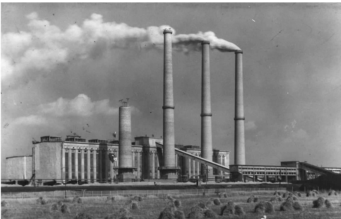
8.kép. A már nagyrészt üzembe helyezett erőmű. A két utolsó kazán szerelés alatt, negyedik kémény építése zajlik. No. 3176
