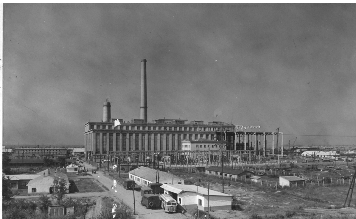
6.kép. Az erőmű egy részét már üzembe helyezték, mialatt az épület másik vége még építés alatt áll. No. 2785
