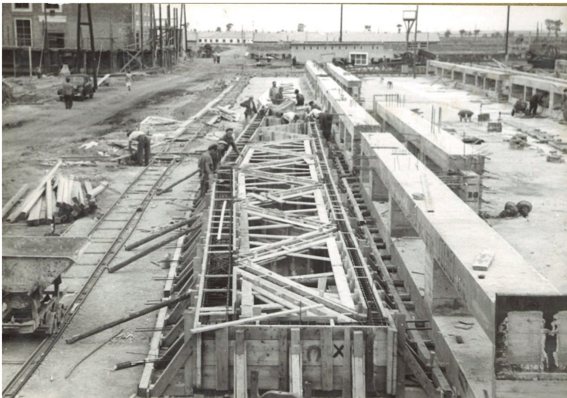
1.kép: A talajon fekvő pillérek és a főtartó zsaluzata No.1563
